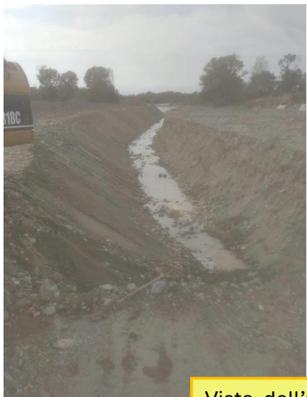
Vista dell'area di cantiere durante lo scavo della savanella sul torrente Lemme
